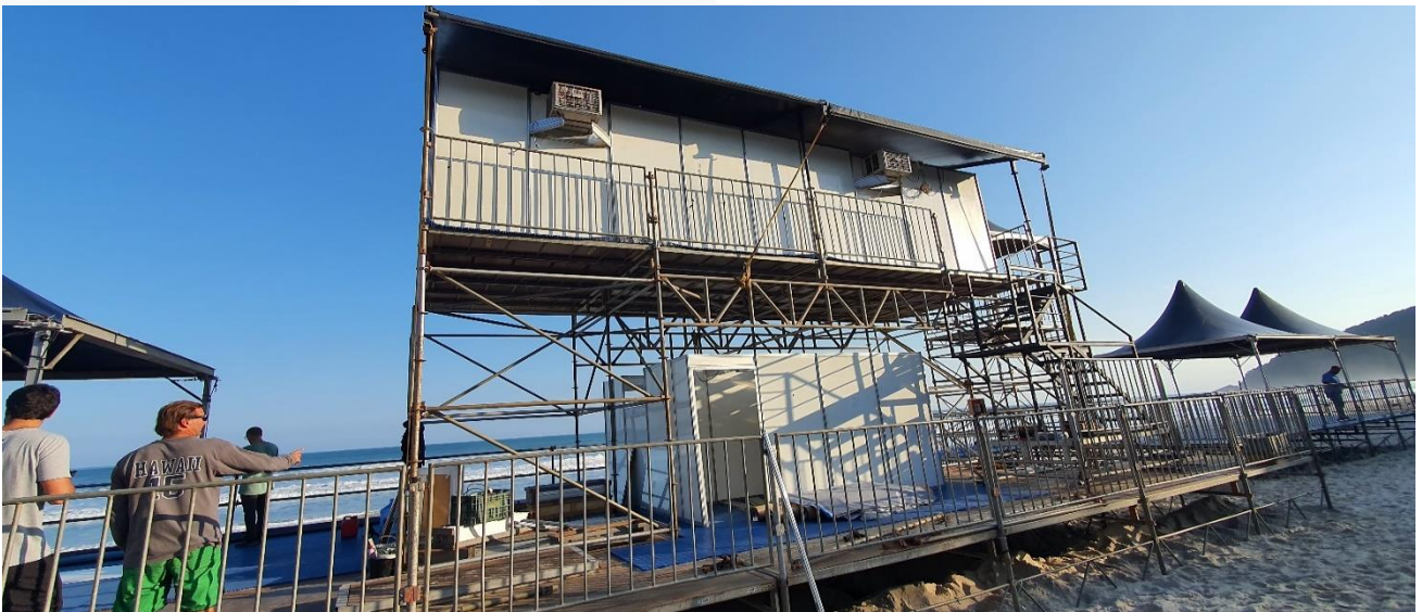
Montagem das Estruturas
