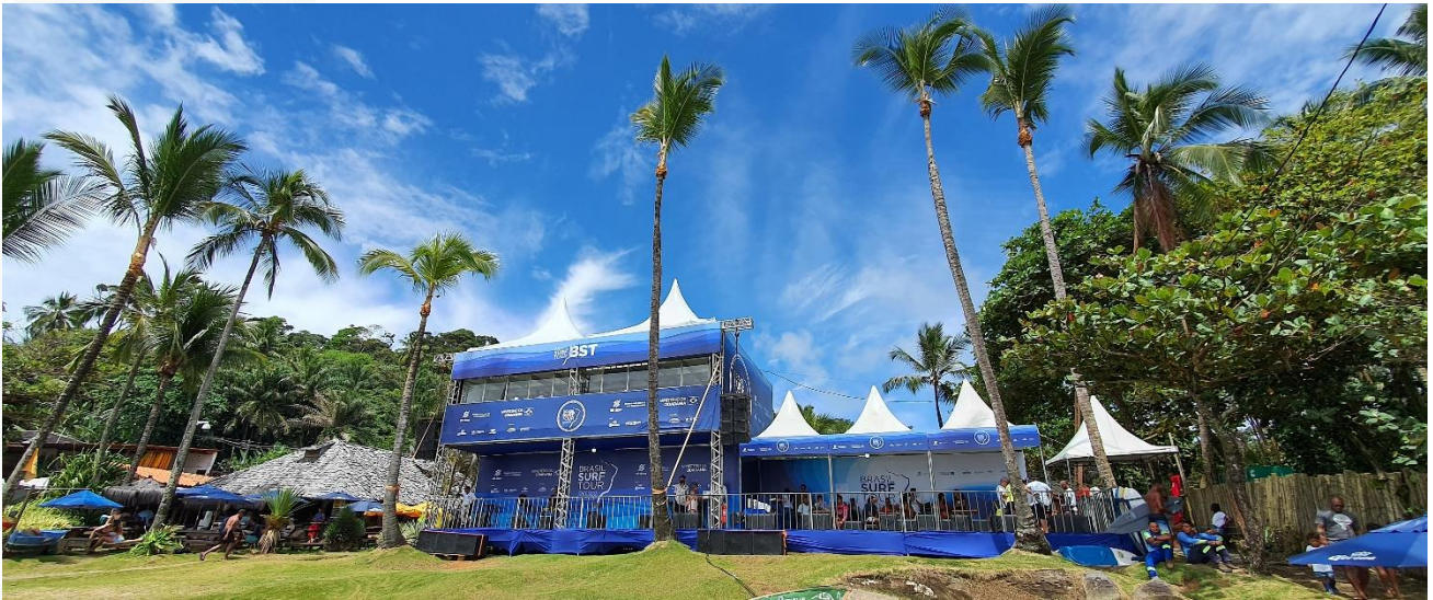
Estrutura pronta para execução da etapa
