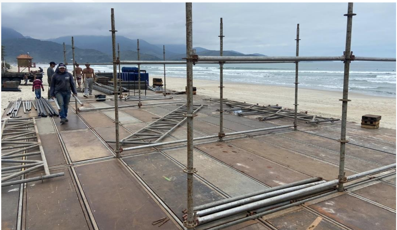
Montagem das Estruturas
