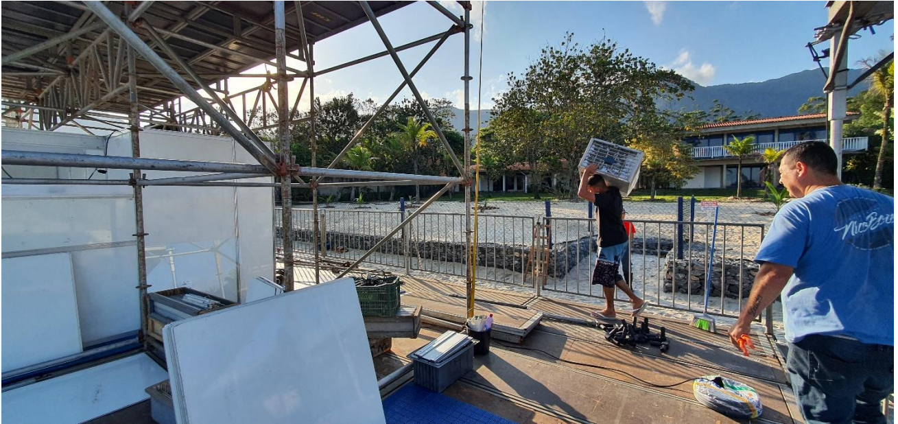
Transporte de material e montagem das estruturas
