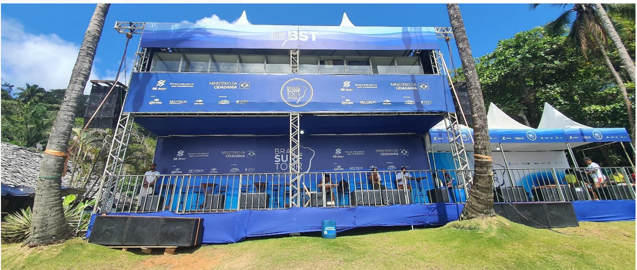
Estrutura pronta para execução da etapa
