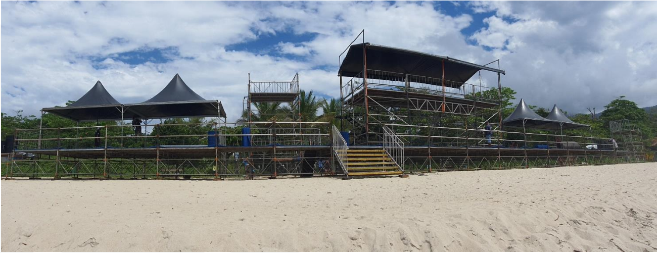
Montagem das estruturas
