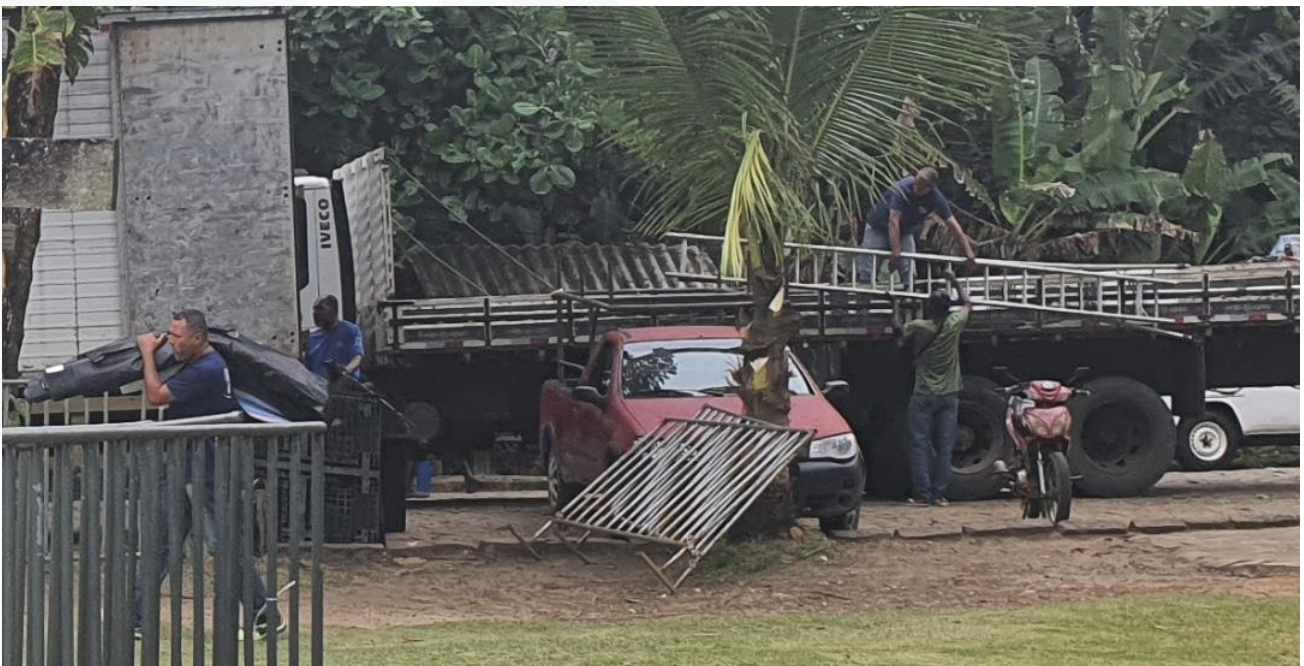
Transporte e montagem das estruturas
