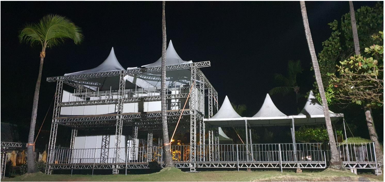
Montagem da estrutura
