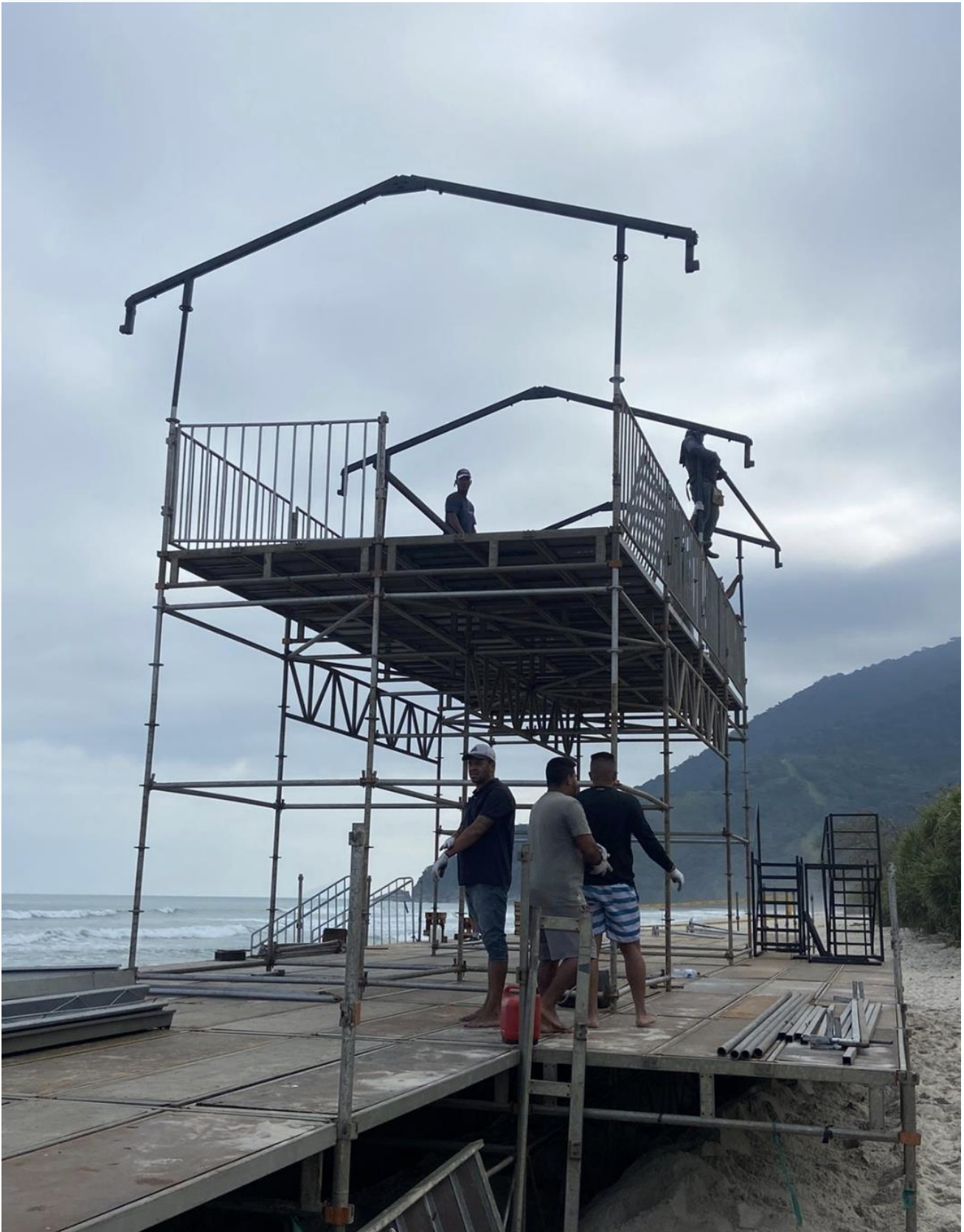
Montagem das estruturas
