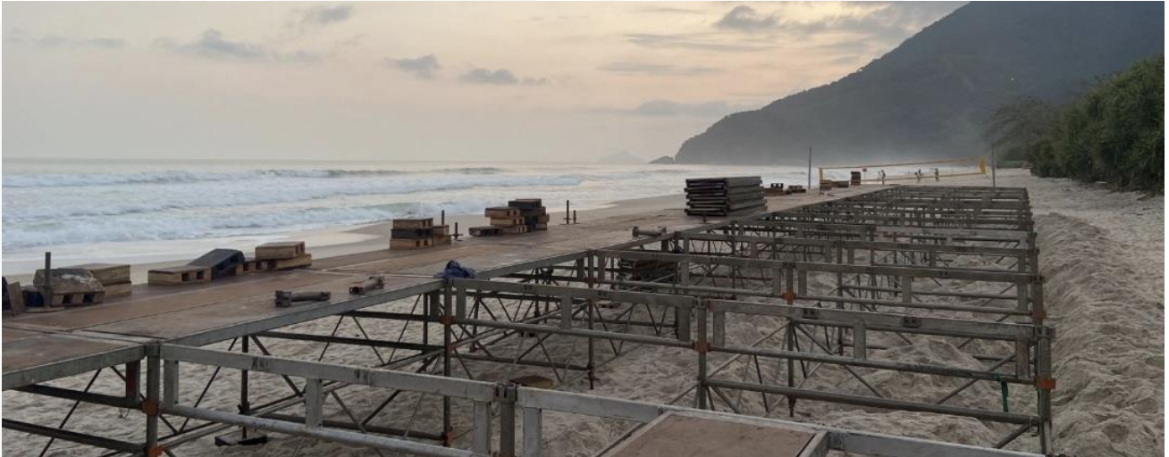
Montagem das Estruturas
