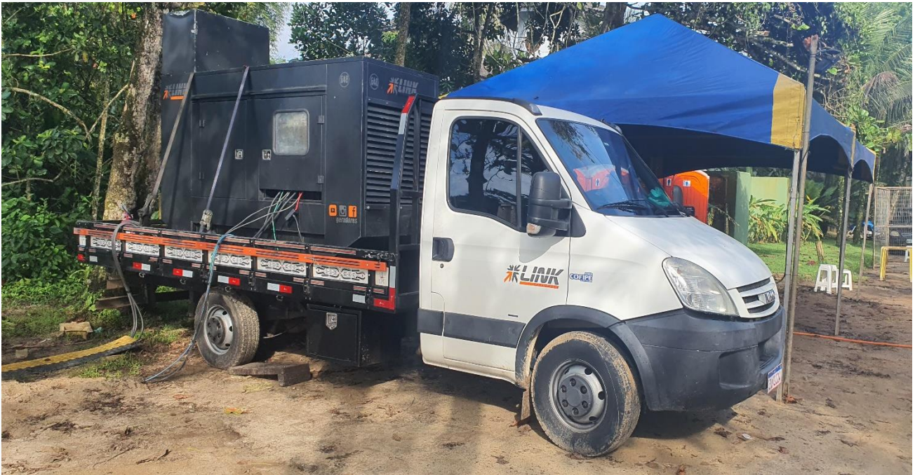
Gerador de energia
