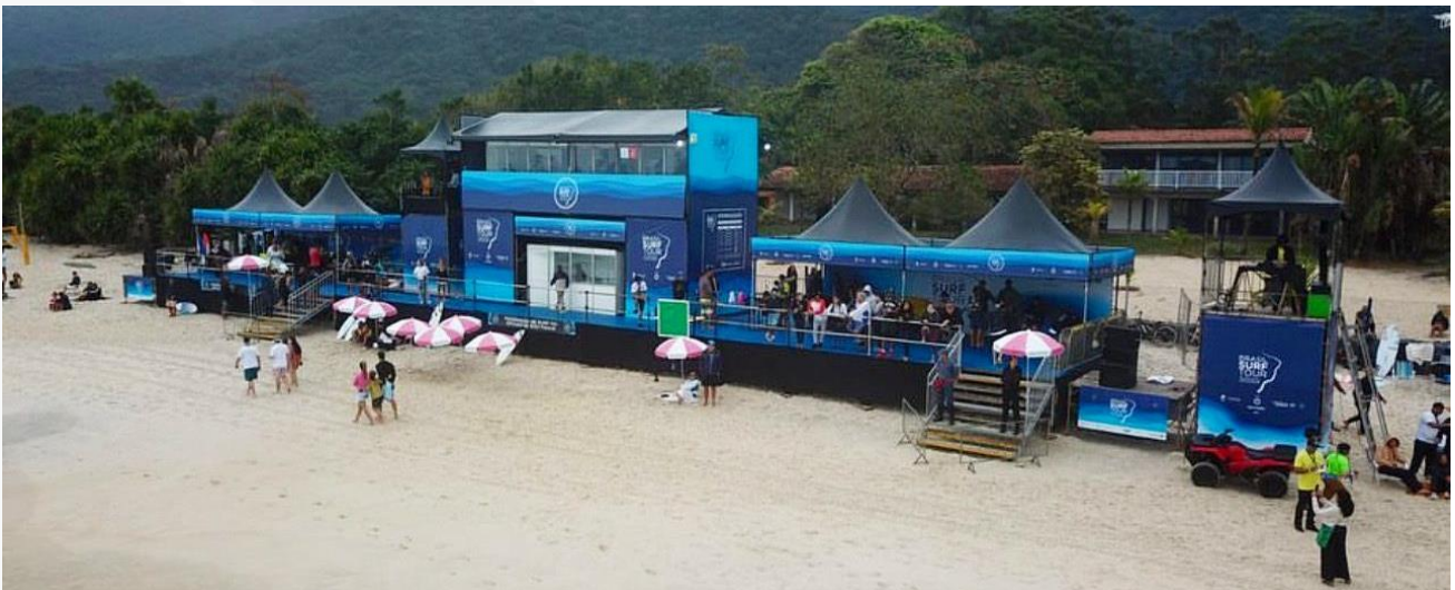
Estrutura da etapa de Maresias
